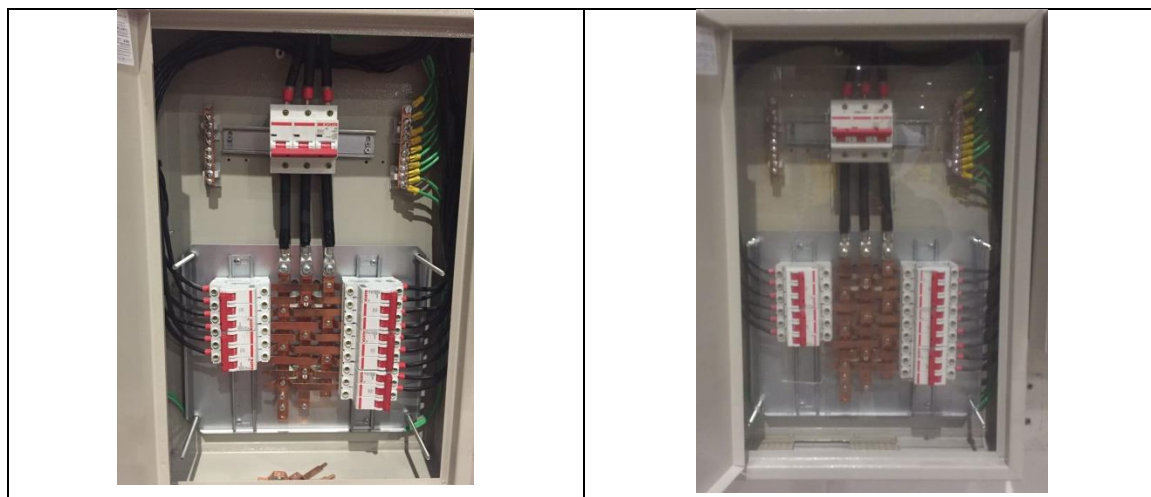
Figura 5 – Versão final do QDFL. Na parte A está sem a barreira de acrílico e na parte B está com a barreira de acrílico.
